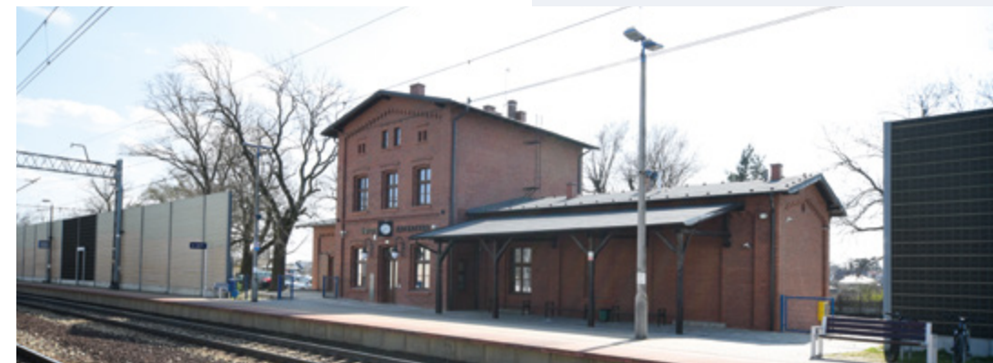
Stacja kolejowa w Świętej Katarzynie
