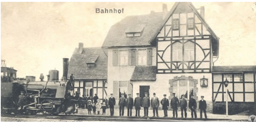
Nieistniejąca stacja kolejowa w Domaniowie
