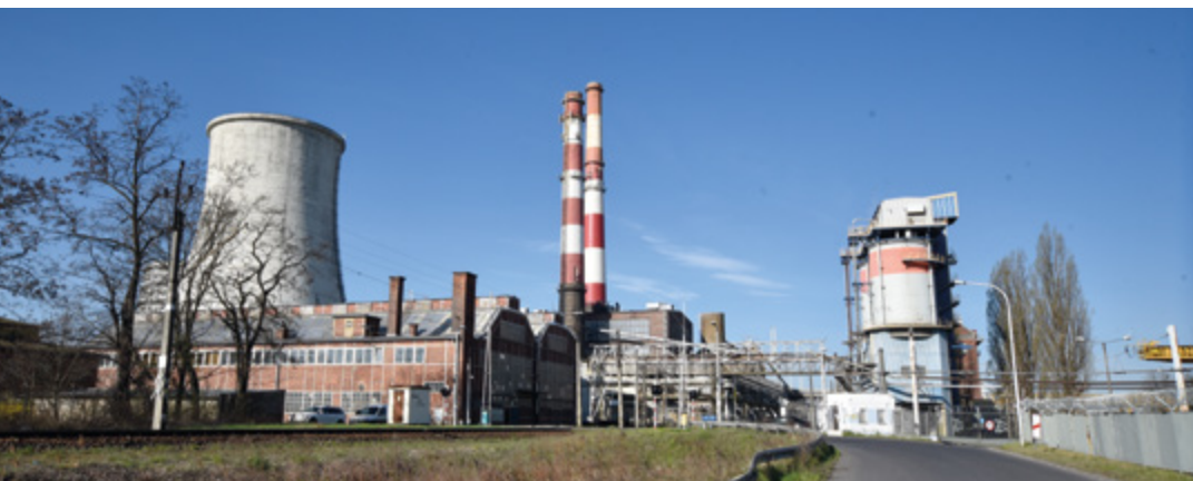
Elektrociepłownia Czechnica w Siechnicach .....
