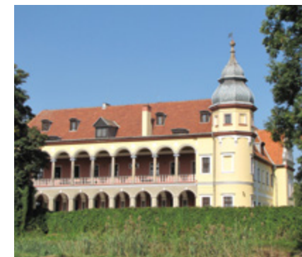
Pałac w Krobielowicach od strony stawów
